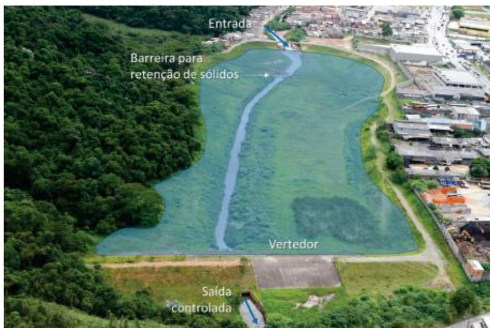
Figura 46 - Reservatório *in-line* de Retenção, Aricanduva 2, em São Paulo
