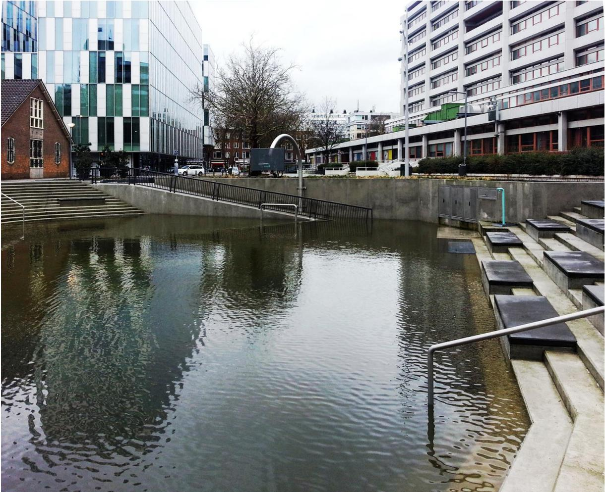
Figura 49 - Exemplo de reservatório multiuso fechado, Watersquare Bentheplein – Rotterdam, Holanda.
