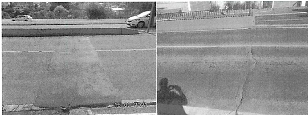
Viaduto Rui Dória
