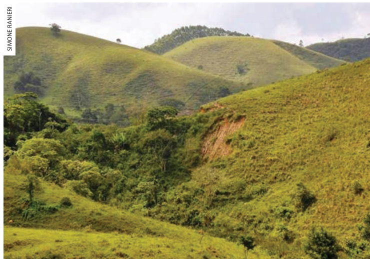
Cicatriz de movimento de massa em relevo montanhoso, deflagrado a partir da retirada da vegetação no entorno do PNM Augusto Ruschi
