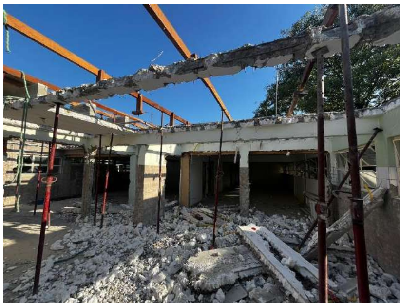
Fase de demolição no espaço onde será o centro cirúrgico
