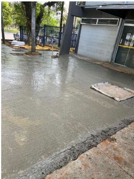
Obra de nivelamento da parte externa
