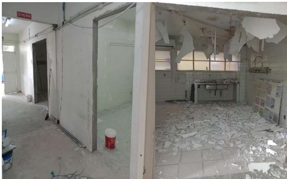
Box de emergência antes
