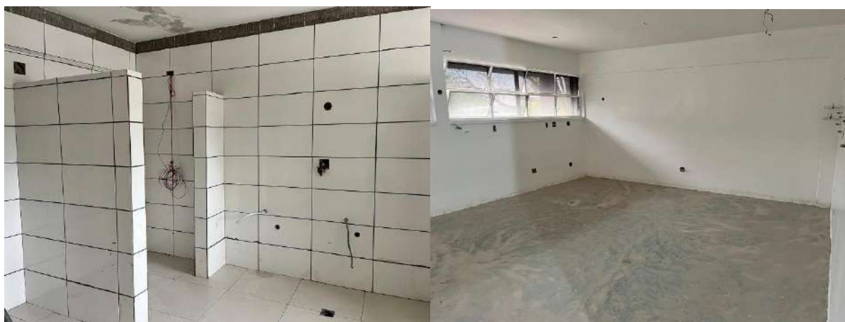
Obras de retrofit nos quartos e banheiros da clínica médica
