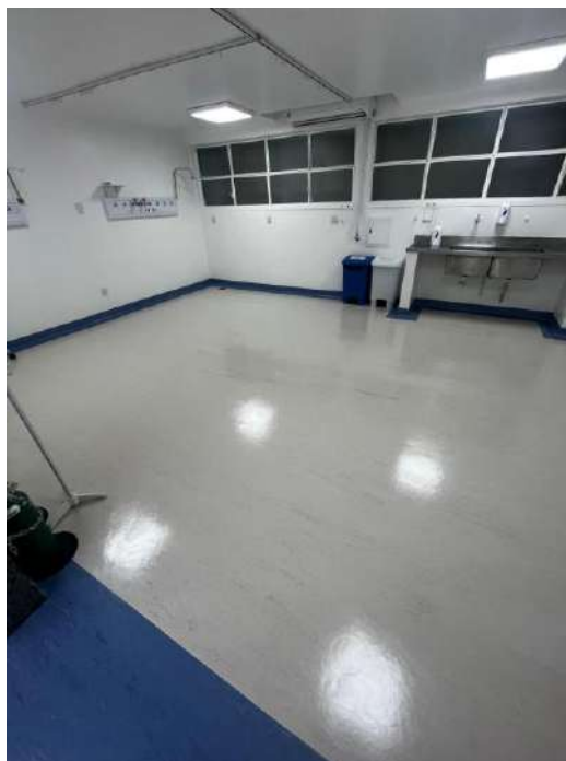
Box de emergência depois
