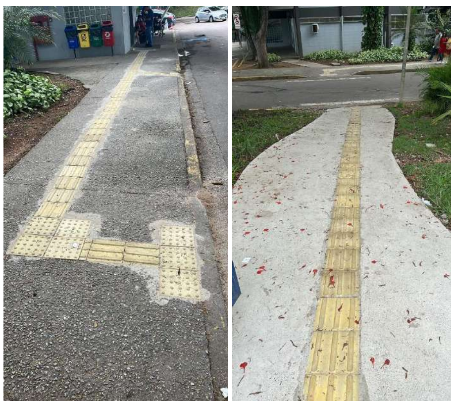
Instalação de piso podotátil
