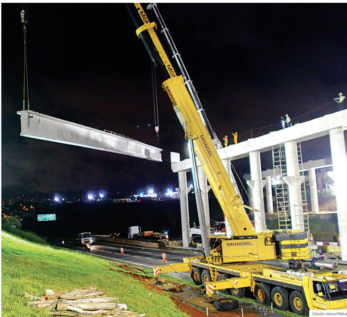
**Viaduto.** Lançamento de vigas na Via Cambuí, em fevereiro: obra do eixo de ligação entre as regiões leste e sudeste avança em ritmo acelerado. Na foto ao lado, construção da escola no Pinheirinho dos Palmares
