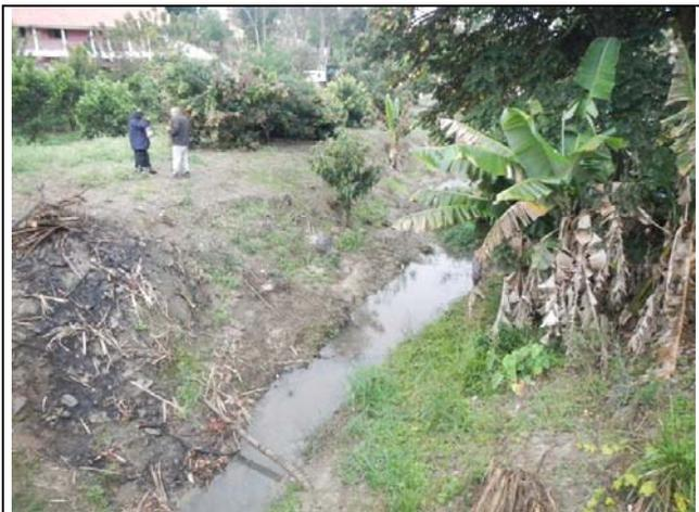
Drenagem que cruza o setor, assoreada, com lançamento de águas servidas e esgotos, lixo e entulhos.
