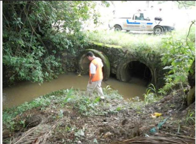
Emboque da canalização da drenagem, em 2 tubos de concreto com  $\Phi=1,5$  m.
