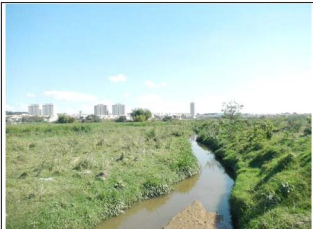
Visão geral de parte do curso do rio, sua calha e área de extravasamento com superfície vegetada. Trecho com assoreamento.
