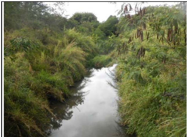
Drenagem que cruza o setor, assoreada, com solapamento nas margens, e lançamento de águas servidas e esgotos.
