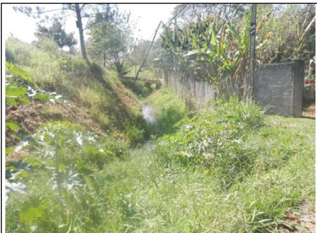
Drenagem retificada, com assoreamento e sua margem direita com solapamento.
