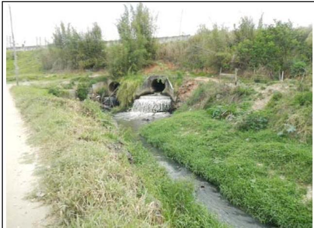
Drenagem canalizada em tubos de concreto de diâmetro 1,5 m, assentada após o evento da inundação do setor, que segundo os moradores, mitigado após a intervenção.
