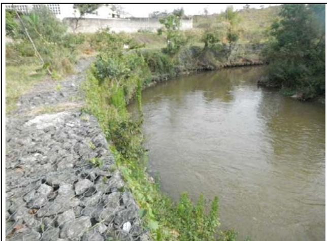
Gabião caixa construído na curva do rio, margem esquerda, intervenção para o solapamento do talude marginal.
