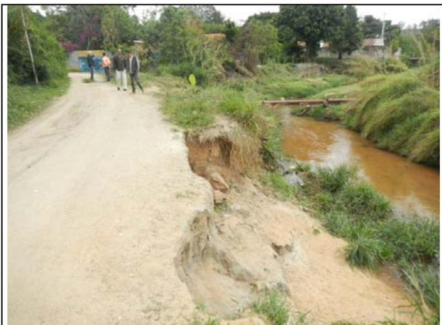
Margem esquerda do córrego, com solapamento de margem atingindo a via de acesso ao setor.
