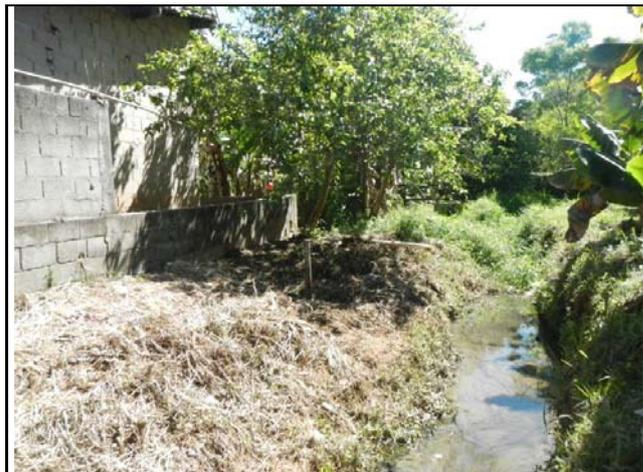
Drenagem assoreada, com solapamento de margem, com lançamento de águas servidas e esgotos.
