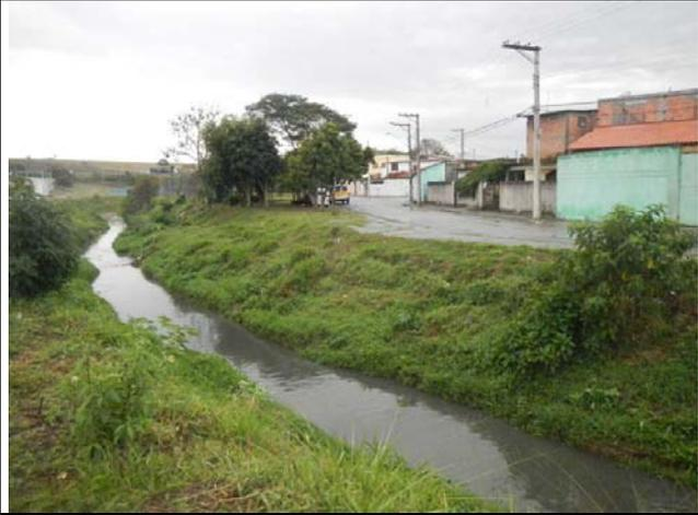
Drenagem que cruza o setor, com seus taludes marginais vegetadas por gramíneas. As moradias da foto, margem direita da drenagem, foram todas afetadas pela inundação.
