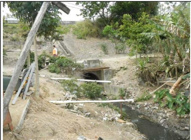
Obras de canalização da drenagem que segundo os moradores, a intervenção mitigou a recorrência das inundações. Notar lançamento de águas servidas e esgotos na drenagem.
