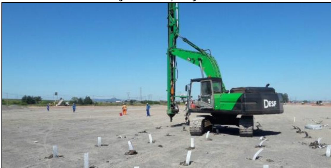
Figura 12 – Cravação do geodreno.
