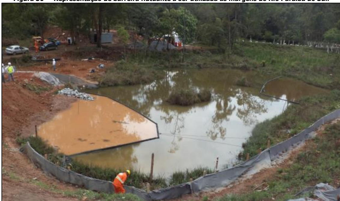
Figura 30 – Representação de barreira flutuante a ser utilizada as margens do Rio Paraíba do Sul.
