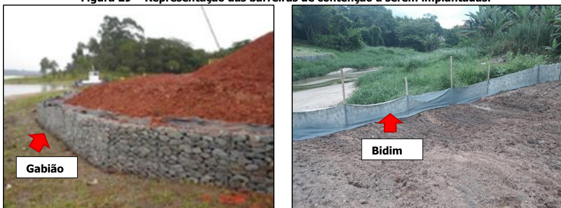
Figura 29 – Representação das barreiras de contenção a serem implantadas.
