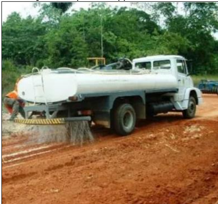
Figura 40 Exemplo caminhão pipa umedecendo o solo.
