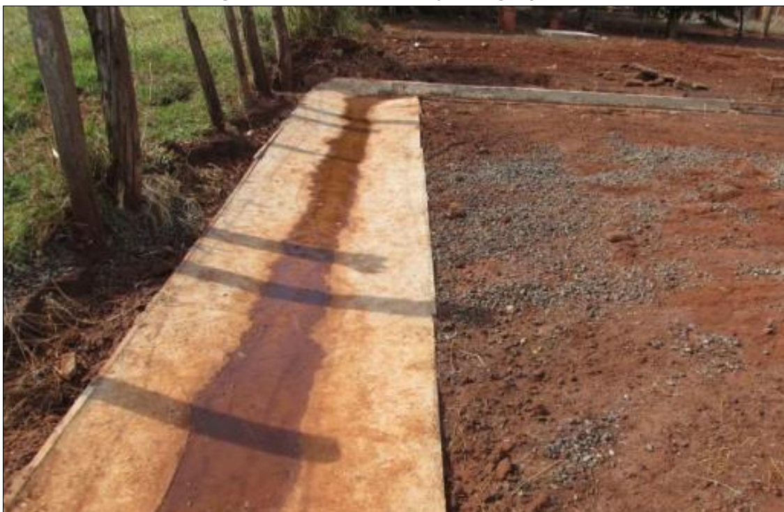
Figura 28 – Canaleta de condução de água pluvial.
