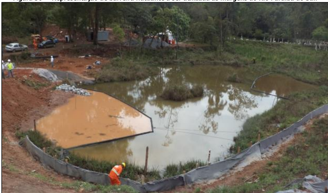
Figura 36 – Representação de barreira flutuante a ser utilizada as margens do Rio Paraíba do Sul.
