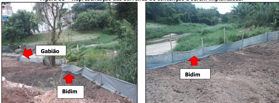
Figura 35 – Representação das barreiras de contenção a serem implantadas.
