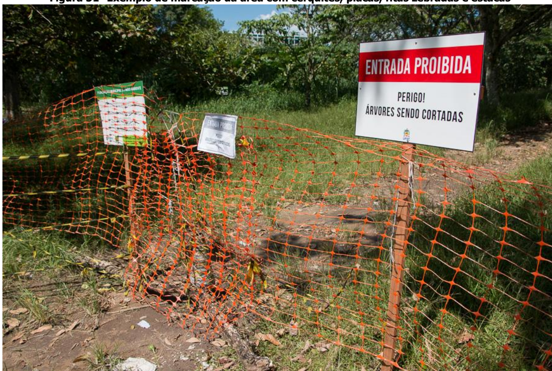
Figura 51- Exemplo de marcação da área com cerquites, placas, fitas zebradas e estacas
