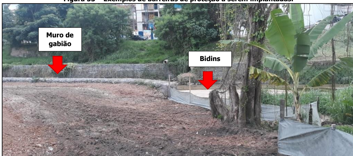
Figura 53 – Exemplos de barreiras de proteção a serem implantadas.
