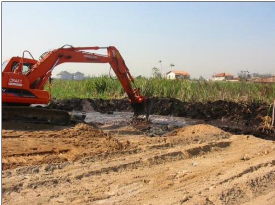
Figura 10 – Exemplo de remoção de solo mole, com objetivo de eliminar os recalques devido o adensamento.
