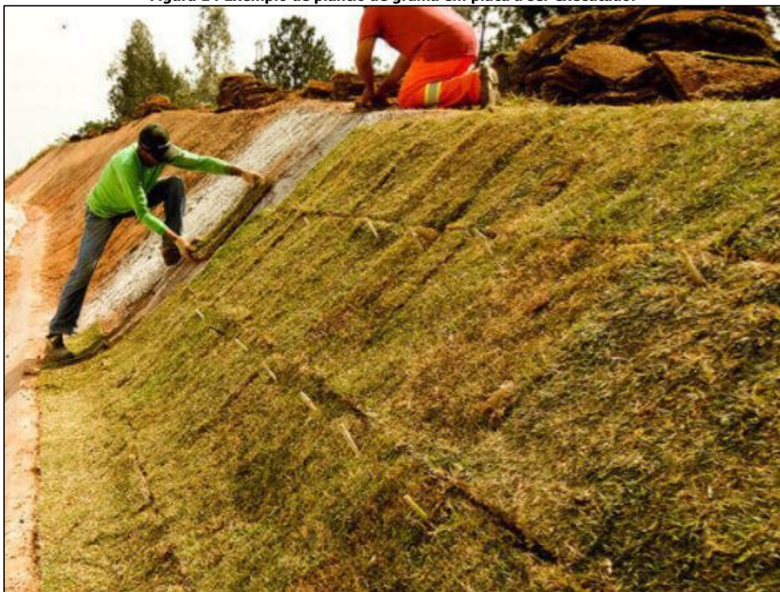
Figura 14 Exemplo de plantio de grama em placa a ser executado.
