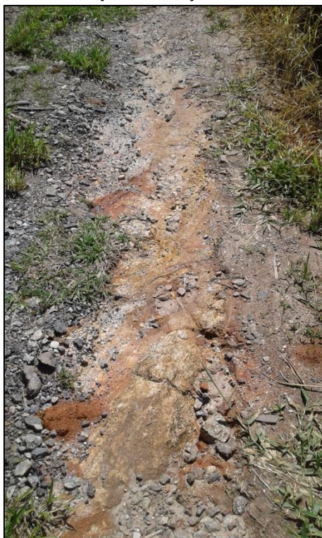
Foto 4 – Detalhe da área próxima à Fábrica da Petybon, onde afloram rochas da Formação Resende (por onde vai passar a via) – Ponto P20.
