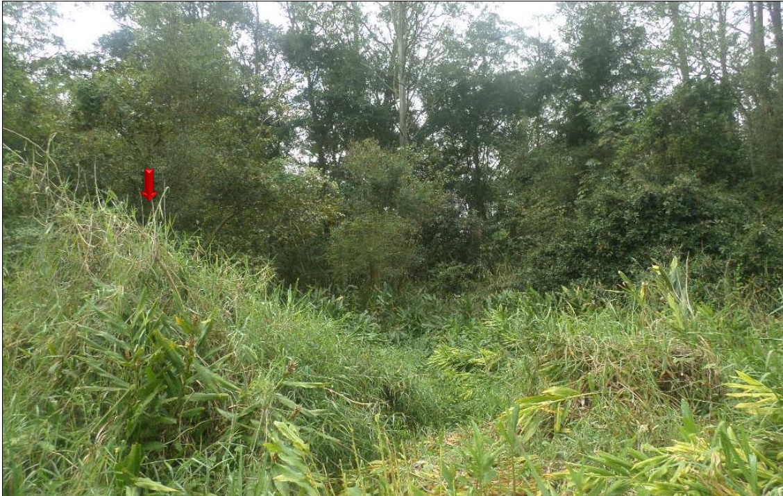
Foto 34 – Destaque para o aterro a jusante do afluente.
