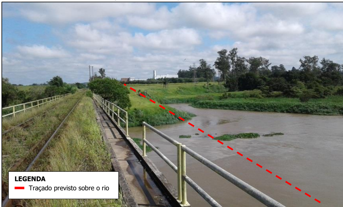
Foto 25 – Vista do rio Paraíba do Sul, local por onde será construída uma ponte para passagem sobre o rio (vista de montante para jusante) – P15.
