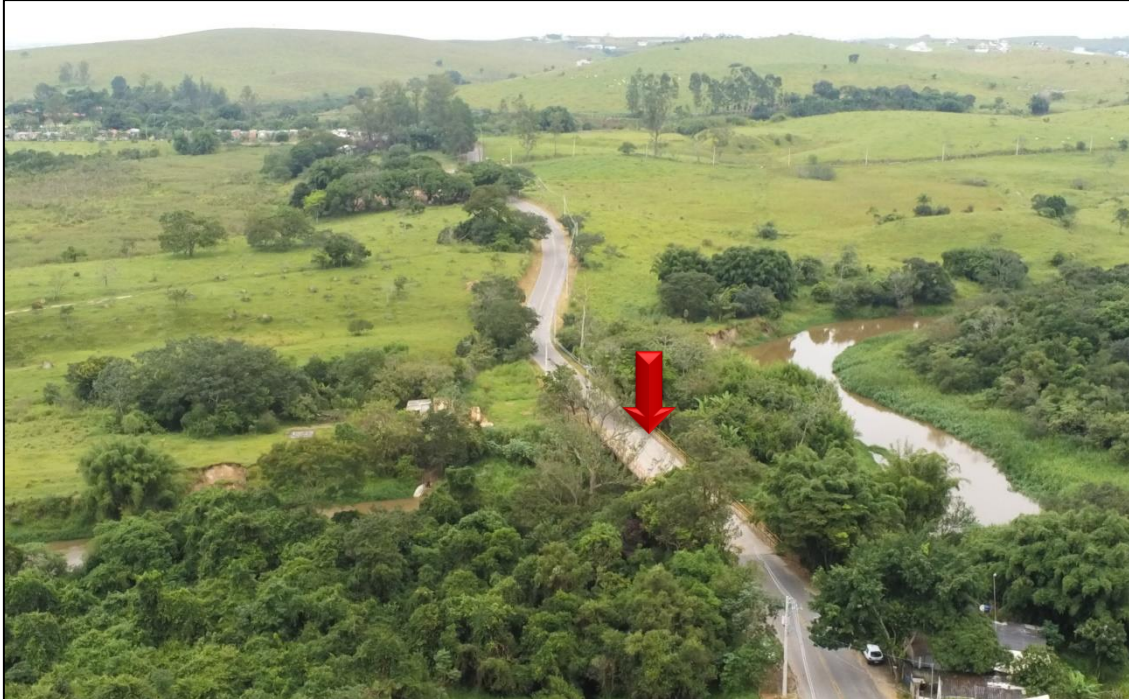
Foto 1 – Ponte sobre o rio Jaguari.
