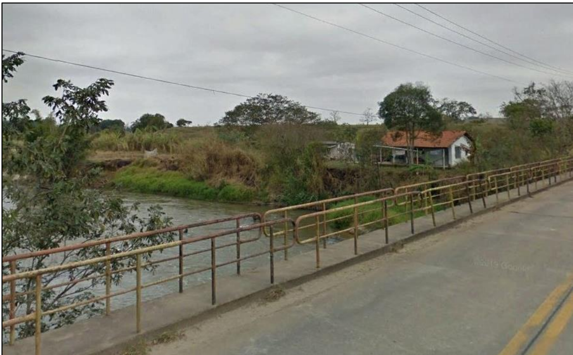
Foto 2 – Ponte sobre o rio Jaguari.
