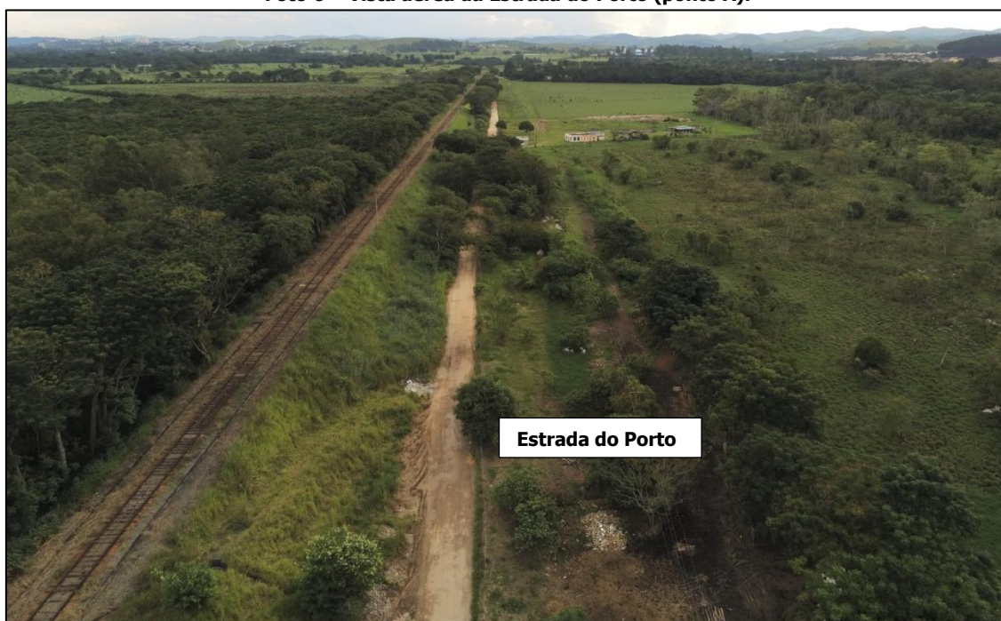
Foto 6 – Vista aérea da Estrada do Porto (ponto A).
