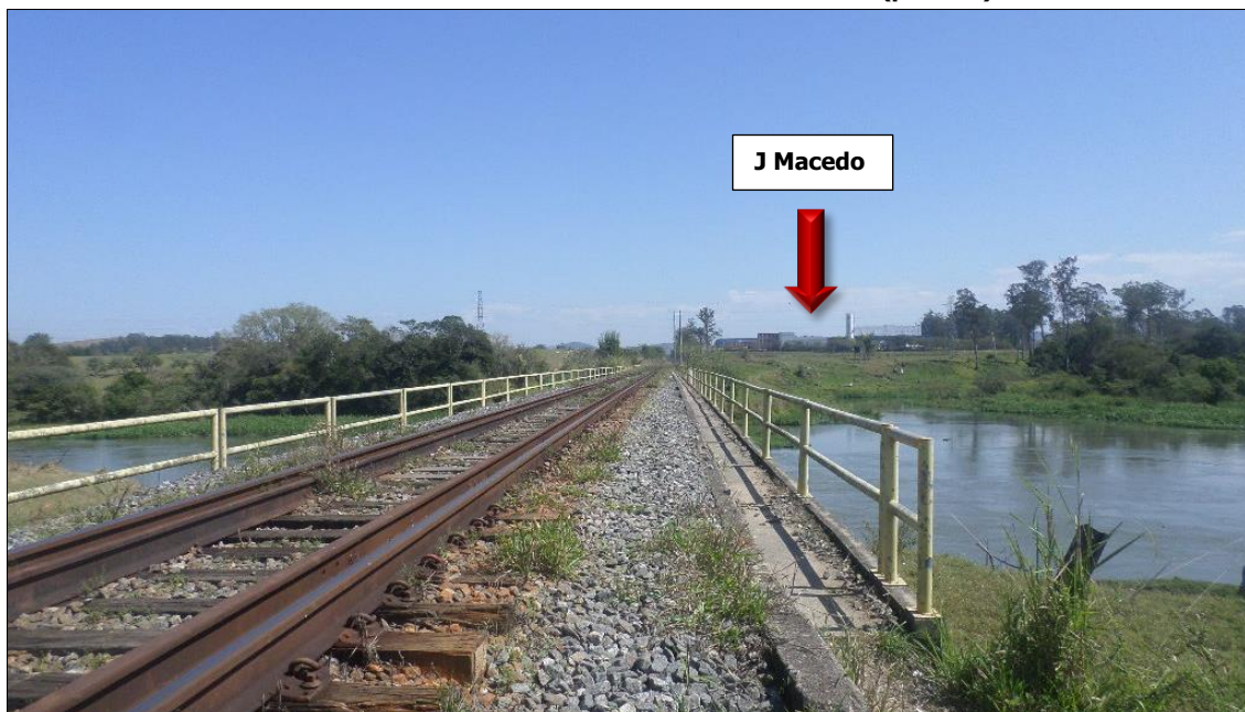
Foto 8 – Ponte da ferrovia sobre o rio Paraíba do Sul (ponto B).
