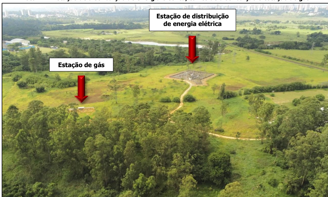
Foto 11 – Estação de distribuição de energia elétrica, torres de distribuição e estação de gás.
