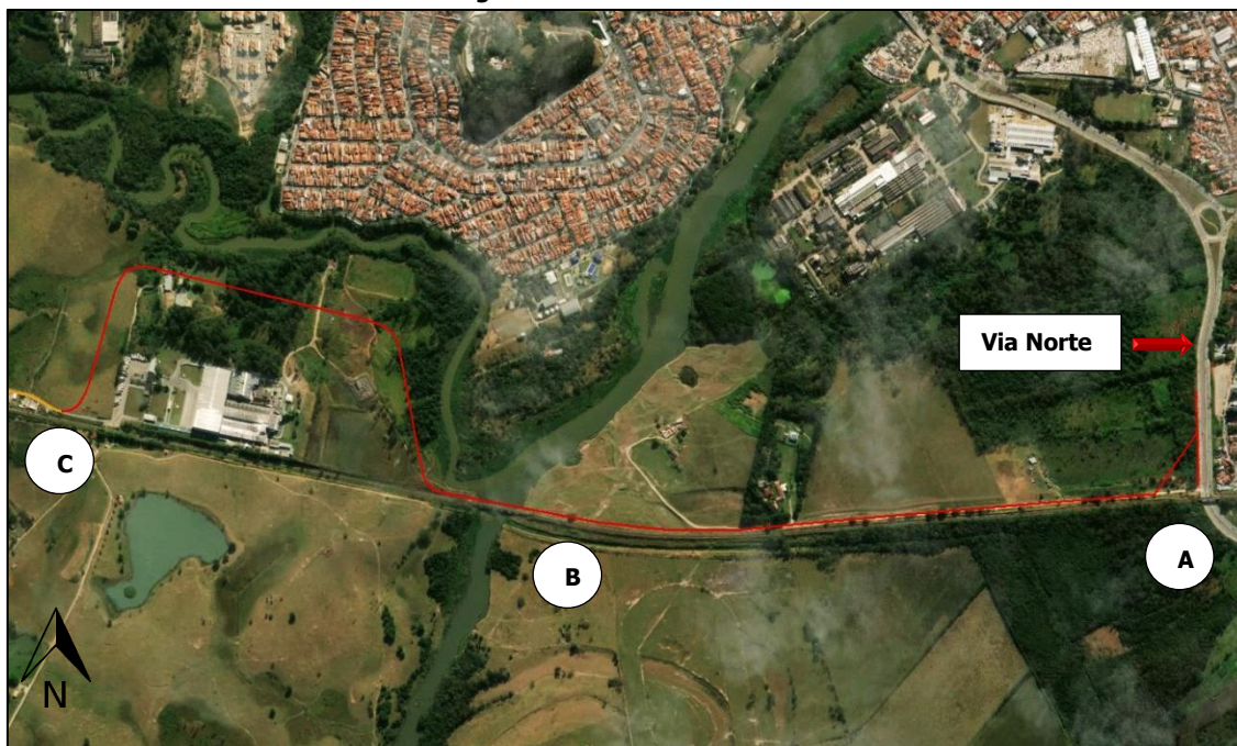
Figura 10 – Trecho 1 da obra.
