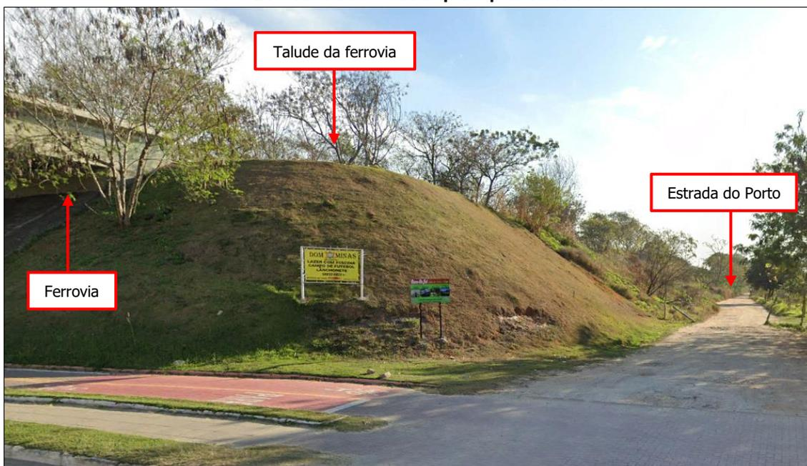
A ampliação da via ocorrerá somente para o lado direito (vista em relação à Foto 24), para que não haja interferência nos taludes existentes da ferrovia, diminuindo ainda mais o impacto sobre a mesma.
