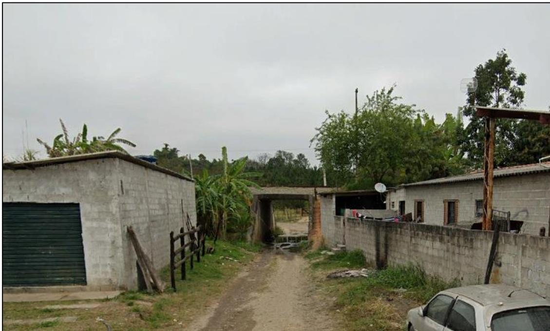
Dessa maneira, a travessia precisaria ser adequada aos padrões do projeto para atender a demanda veicular prevista. A melhor alternativa de adequação seria por método não destrutivo, de forma a diminuir o impacto sobre a ferrovia e não causar danos aos taludes existentes.
