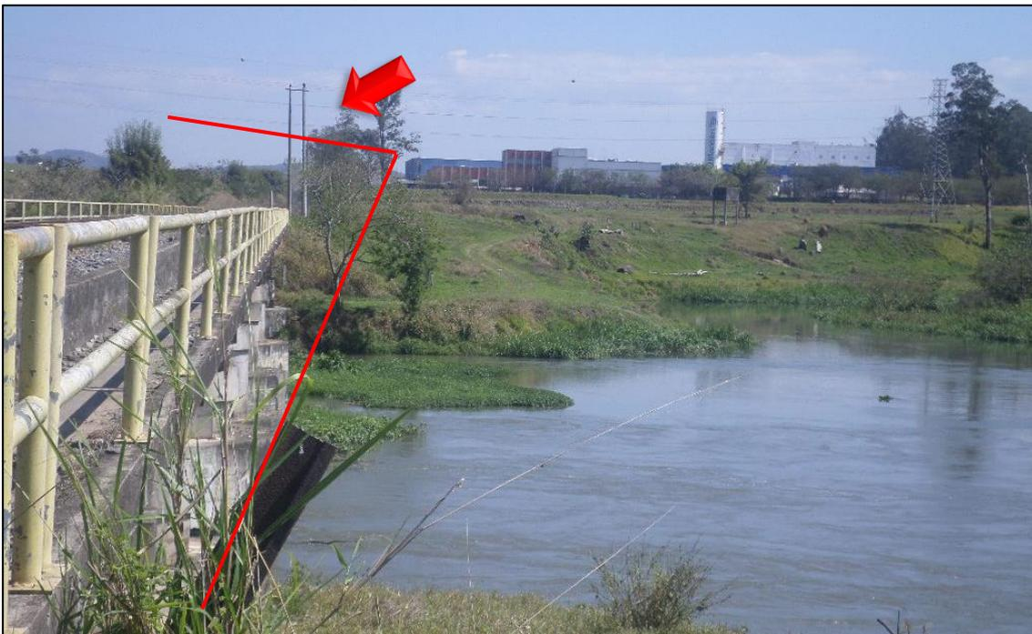
Por se tratar de uma área de várzea, o projeto de implantação da OAE deve ser estruturado para solo hidromórfico, elevando significativamente os custos e a complexidade da obra. As fundações por estacas, de no mínimo 30,0 metros de profundidade em detrimento do solo da região, devem ocorrer através de escavações profundas, abaixo do lençol freático, e
