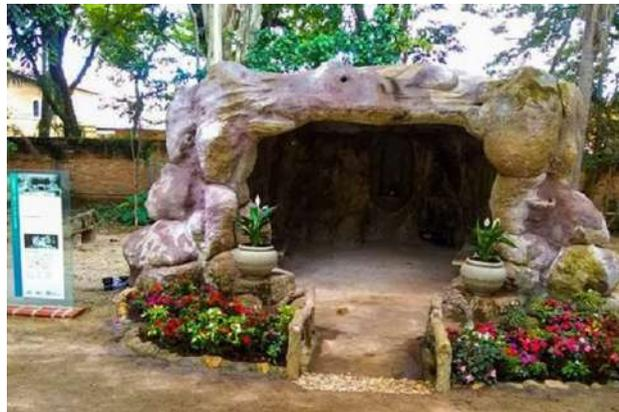
As ações de conservação preveem a remoção da vegetação, a vedação de trincas e a recomposição do revestimento. Os jardins originais tiveram seus contornos devidamente recompostos com tijolos, conforme o padrão original.
